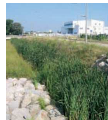
Montpellier - Parc d'activités "Fréjorgues 2" - Noue végétalisée
