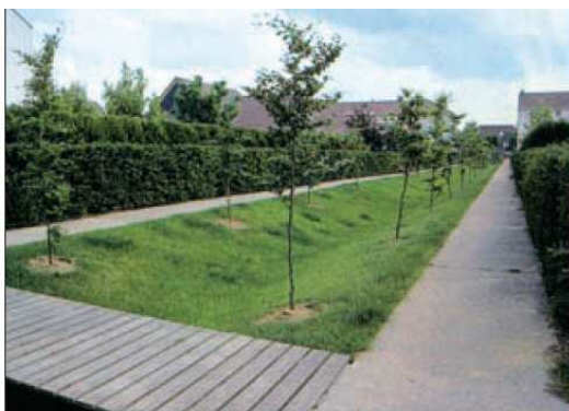
La double fonction d'une noue : le stockage et la régulation des eaux de pluie ainsi que l'agrément paysager.
