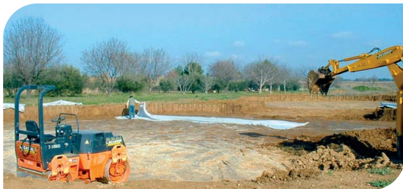
Début des travaux à Lunel Viel
