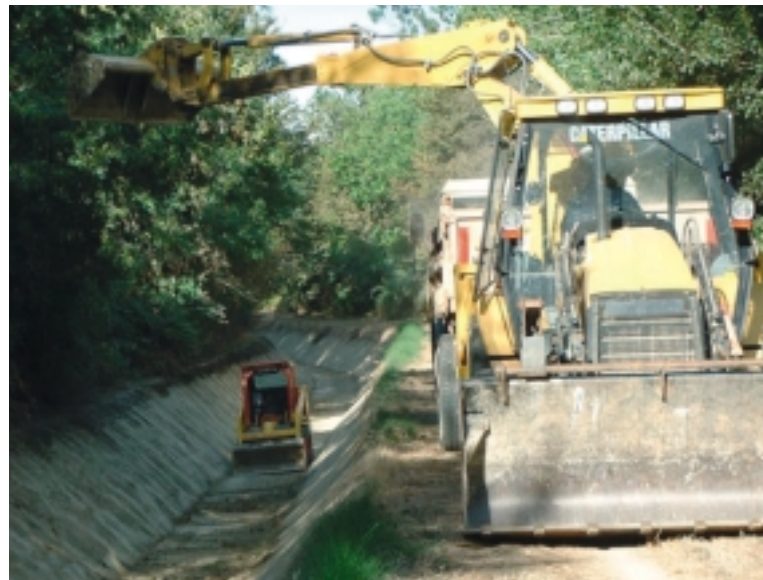
Curage du canal d'aménée d'eau du Vidourle. (photo SMGEO)
