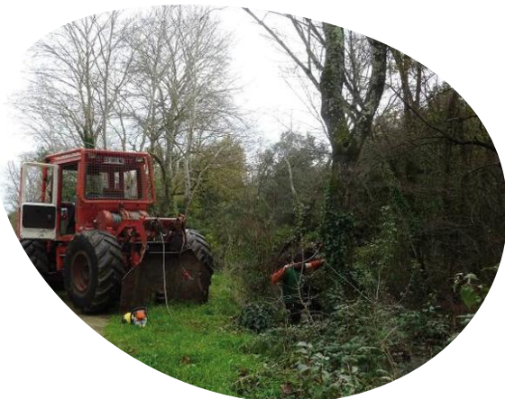
Intervention sur le Valentibus à Sussargues
