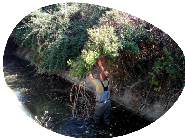
Canal d'amenée d'eau douce du Vidourle
